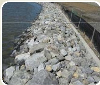
Rock Riprap Revetment
